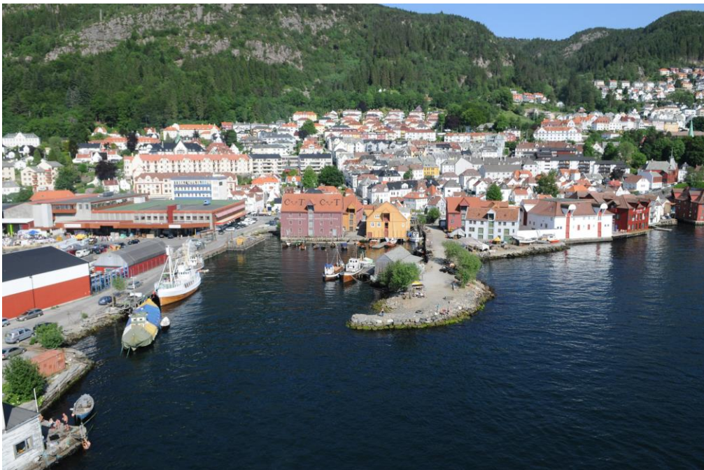
Havnen sett mot øst. Som bildet viser, er det åpent rett inn fra vest. Den lille moloen midt på bildet gir minimal beskyttelse.
