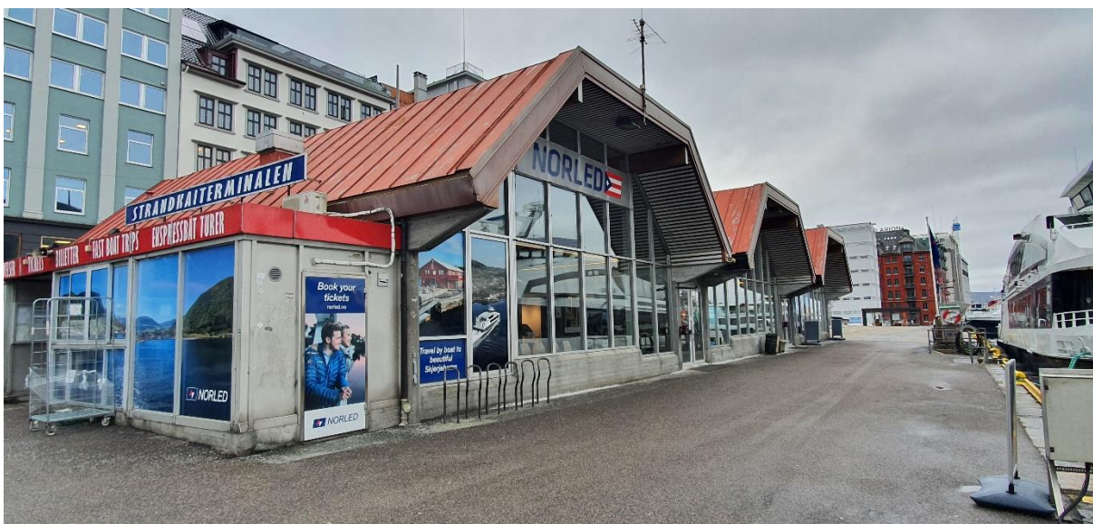
Strandkaiterterminalen er et forholdsvis moderne og romslig bygg som med enkle grep kan bli funksjonelt for BNV. Eventuelt i sambruk med andre.
